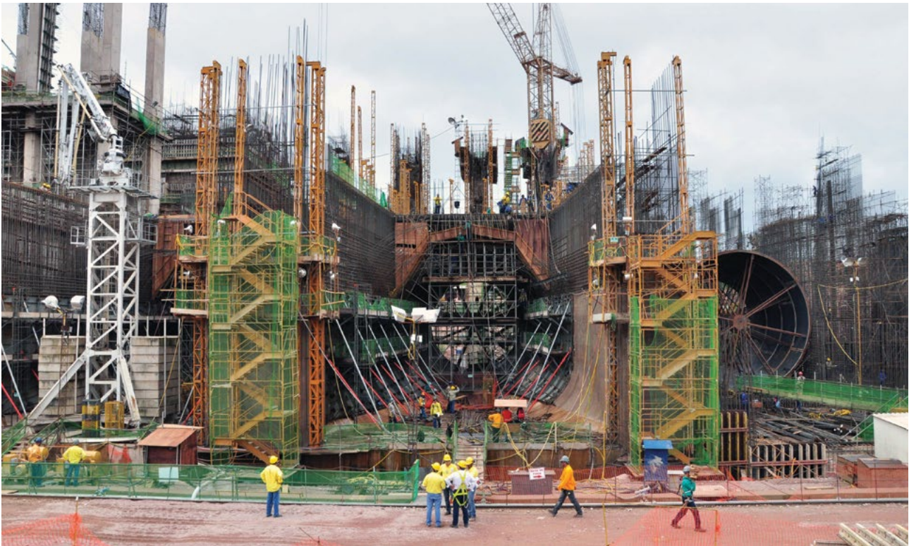
As obras de construção civil de Jirau foram iniciadas em 2009, e a montagem eletromecânica das turbinas, em 2010.
