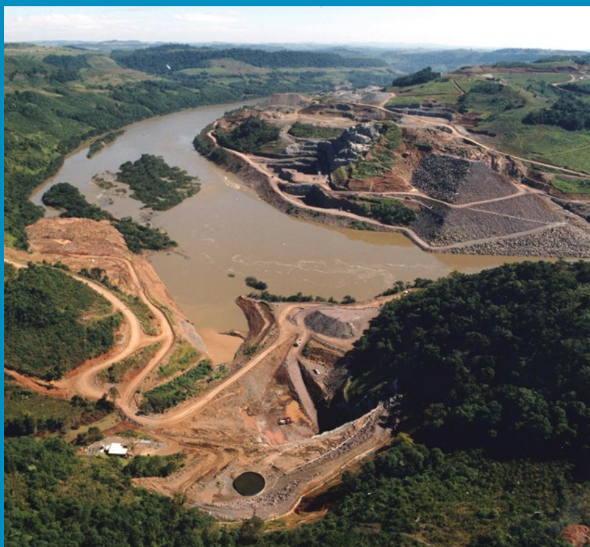
HIDRELÉTRICA MACHADINHO em construção
