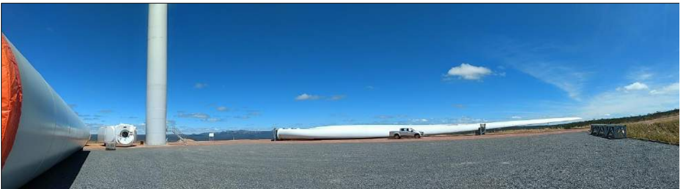
Figura 15. Base do aerogerador 11, Parque IV, Complexo Eólico Campo Largo - Fase 1, durante etapa de montagem dos componentes do aerogerador.
