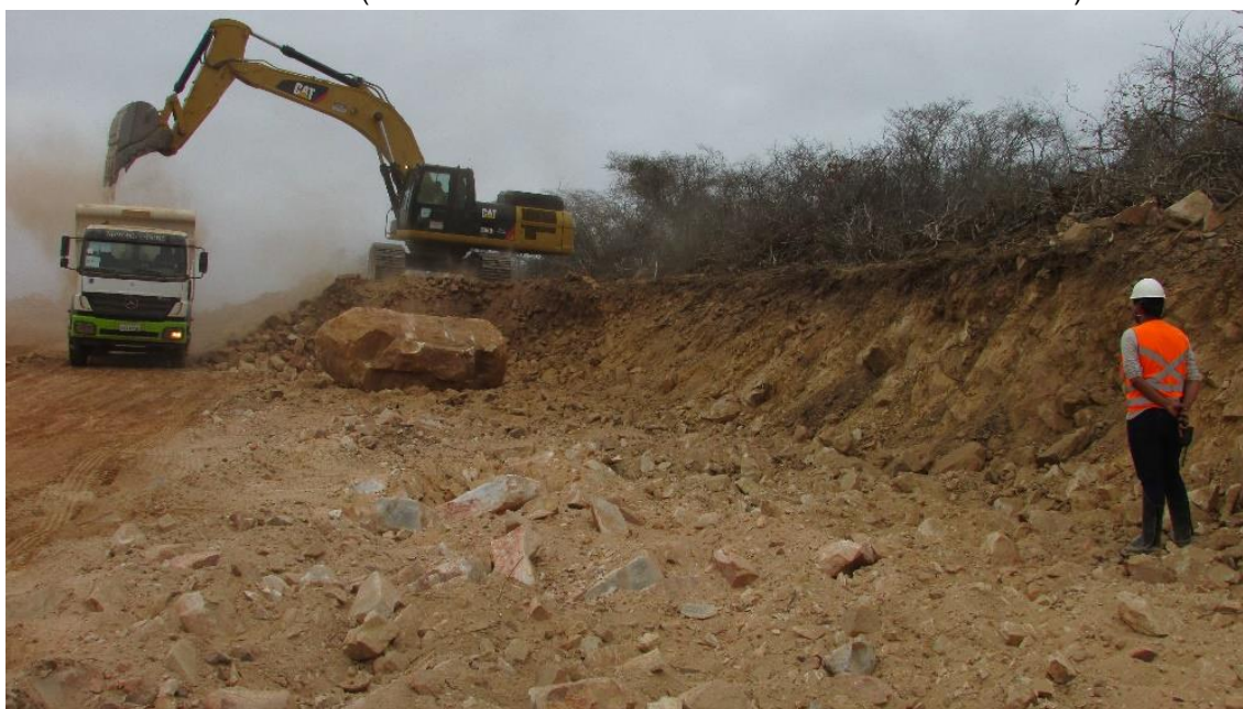
Figura 37 - Monitoramento arqueológico das atividades de terraplanagem e alargamento da via do acesso 09. (COORDS UTM SIRGAS 2000 24 L 0230198/8835297).
