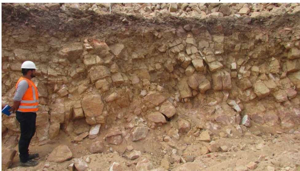
Figura 25 - Registro do perfil estratigráfico da base do aerogerador 08. (COORDS UTM SIRGAS 2000 24 L 0231609/8837368).
