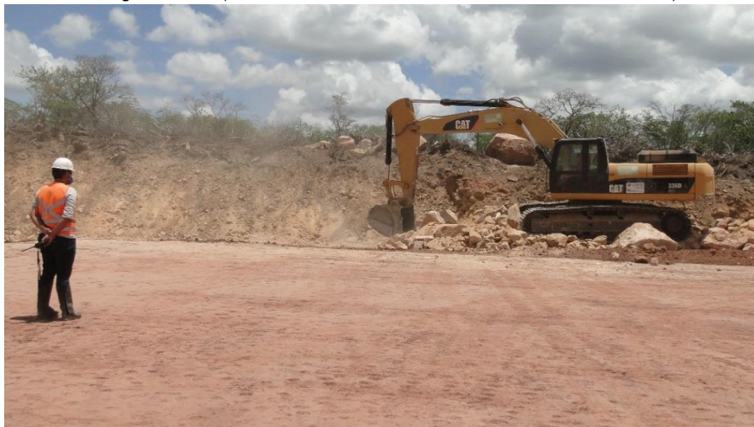
Figura 50 - Monitoramento arqueológico da remoção de sedimento da margem da praça do aerogerador 08. (COORDS UTM SIRGAS 2000 24 L 0230220/8835275).
