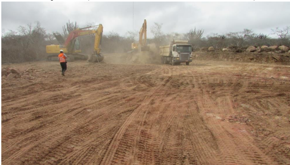
Figura 27 - Acompanhamento arqueológico das atividades de terraplanagem da praça do aerogerador 04. (COORDS UTM SIRGAS 2000 24 L 0230918/8836281).
