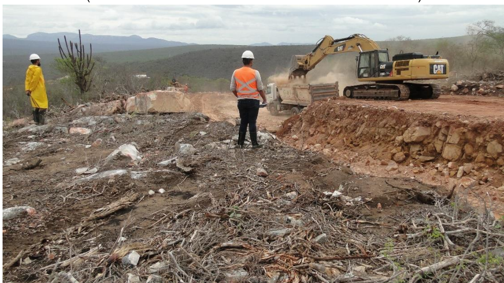
Figura 48 - Acompanhamento arqueológico de retirada de sedimento da via do Acesso 09. (COORDS UTM SIRGAS 2000 24 L 0230155/8835195).
