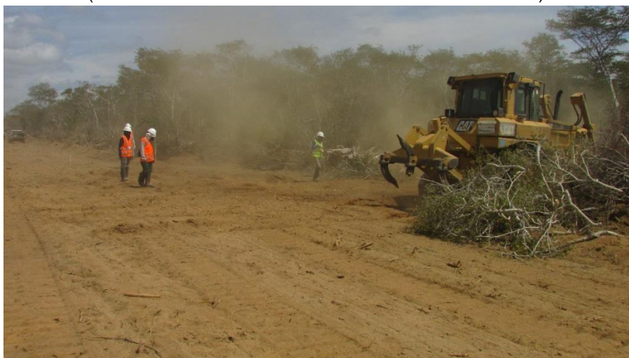
Figura 8 - Acompanhamento de atividade com trator de esteira realizando supressão vegetal. (COORDS UTM SIRGAS 2000 24 L 0227534/8836876).
