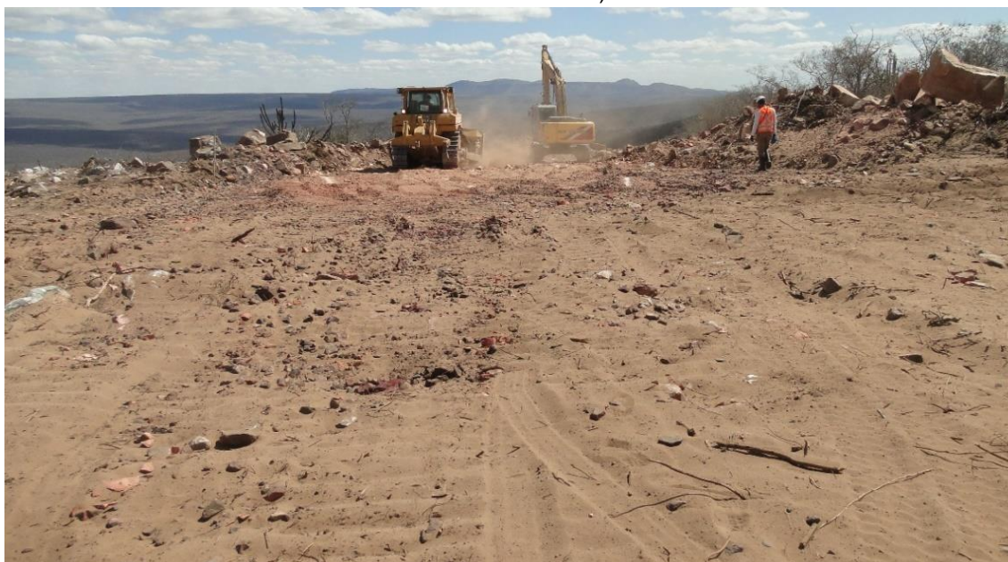
Figura 34 - Monitoramento arqueológico das atividades de terraplanagem na via de acesso com ligação entre os aerogeradores 08 e 09. (COORDS UTM SIRGAS 2000 24 L 0230169/8835209).
