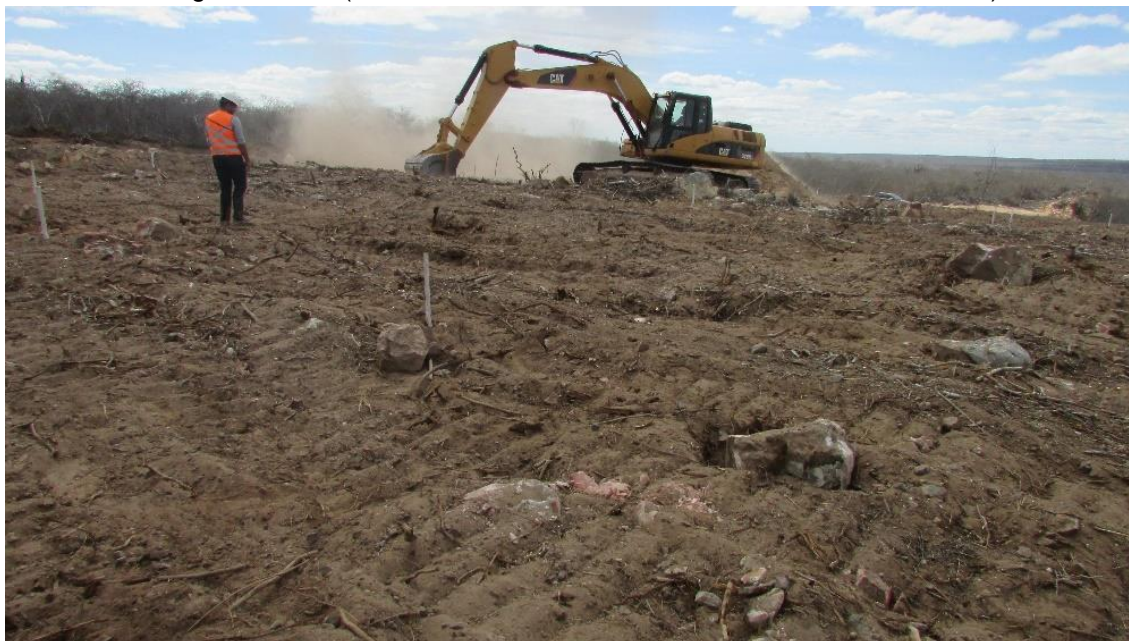
Figura 36 - Acompanhamento arqueológico das atividades de escavação da base do aerogerador 10. (COORDS UTM SIRGAS 2000 24 L 0228120/8836612).
