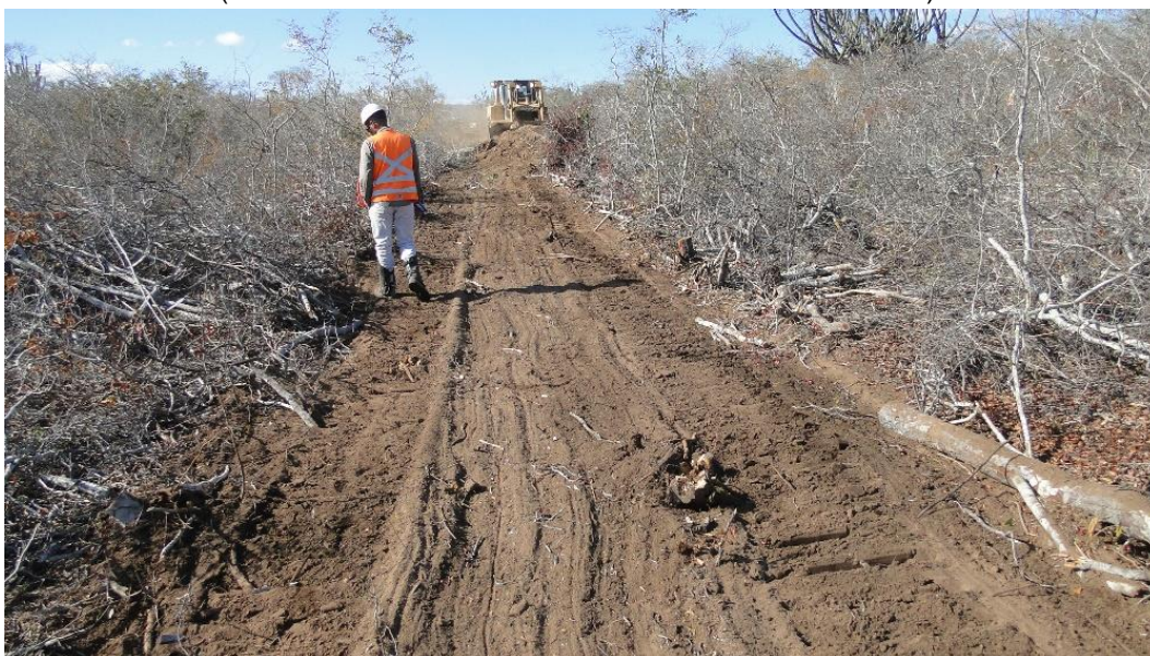
Figura 14 - Equipe técnica de arqueologia realizando inspeção na via do Acesso 09. (COORDS UTM SIRGAS 2000 24 L 0230935/8836303).
