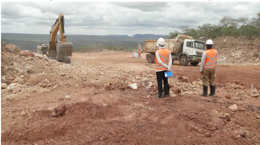
Figura 53 - Acompanhamento arqueológico da atividade de abertura da via do Acesso 09. (COORDS UTM SIRGAS 2000 24 L 0230192/8835241).
