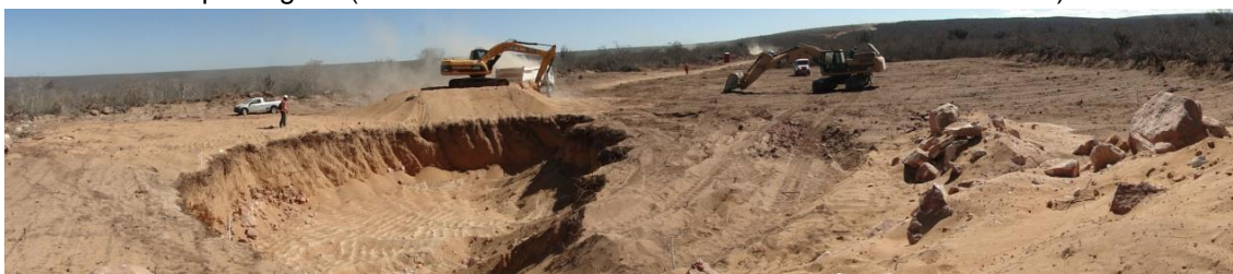
Figura 20 - Vista geral da praça do aerogerador 03 durante a realização do monitoramento arqueológico. (COORDS UTM SIRGAS 2000 24 L 0231080/8836467).
