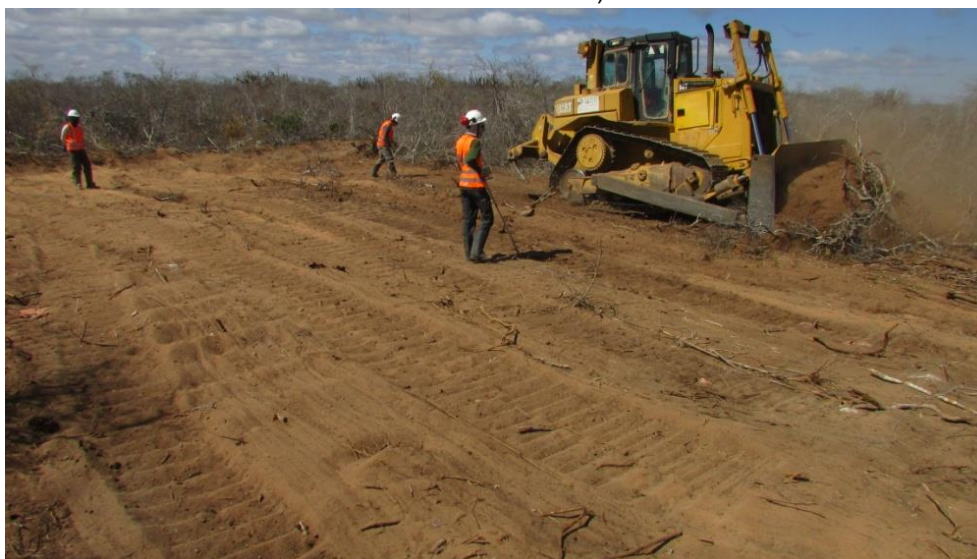
Figura 18 - Equipe de arqueologia monitorando as atividades de supressão vegetal mecanizada da base do aerogerador 02. (COORDS UTM SIRGAS 2000 24 L 0231078/8836561).
