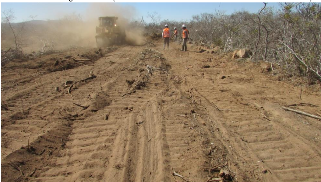
Figura 17 - Acompanhamento arqueológico das atividades de supressão vegetal mecanizada na base do aerogerador 02. (COORDS UTM SIRGAS 2000 24 L 0231197/8836770).
