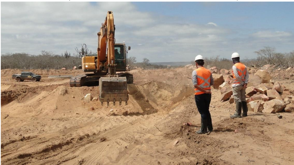
Figura 45 - Acompanhamento arqueológico da remoção de sedimento na base do aerogerador 03. (COORDS UTM SIRGAS 2000 24 L 0231102/8836566).
