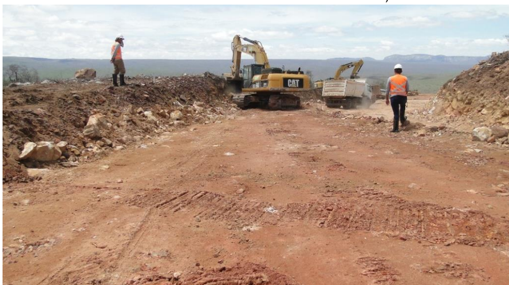
Figura 49 - Acompanhamento arqueológico da abertura da estrada do Acesso 09. (COORDS UTM SIRGAS 2000 24 L 0230174/8835215).
