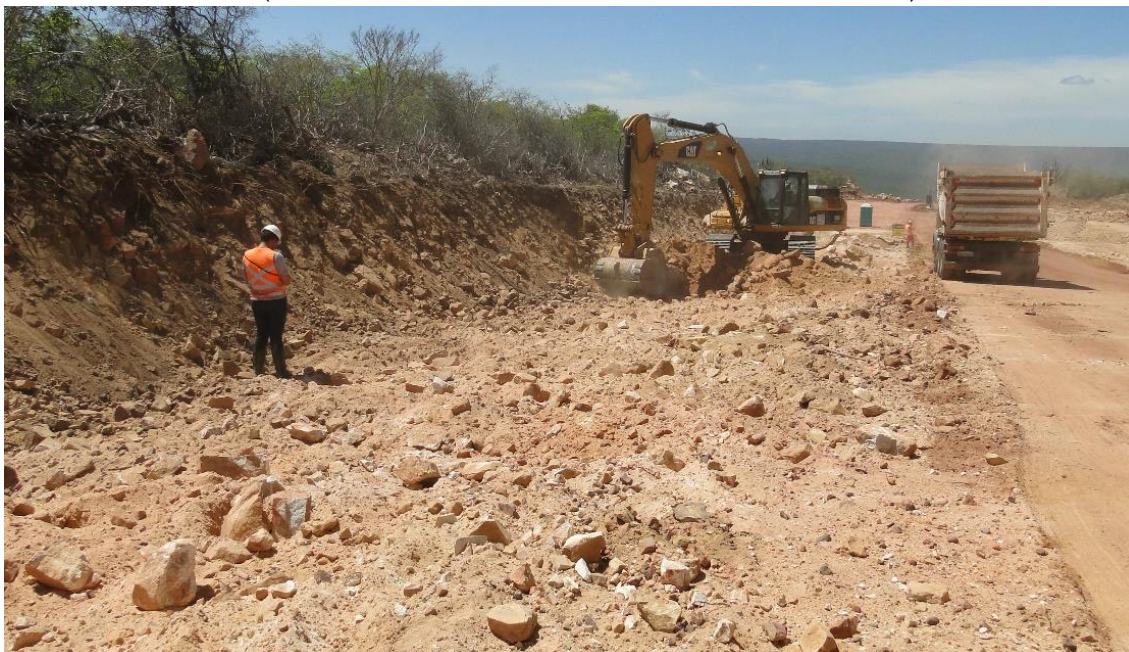
Figura 51 - Monitoramento arqueológico das obras de terraplanagem e alargamento do Acesso 09. (COORDS UTM SIRGAS 2000 24 L 0230255/8835397).
