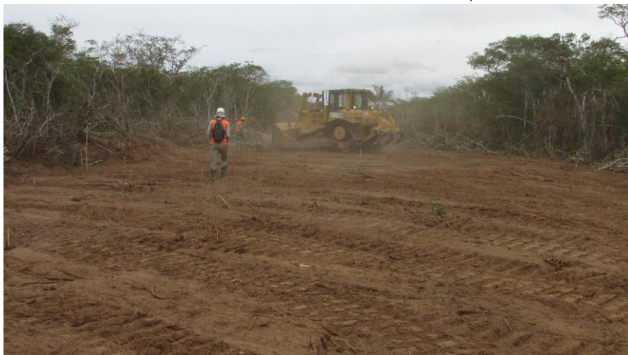
Figura 2 - Acompanhamento do maquinário na retirada do material lenhoso. (COORDS UTM SIRGAS 2000 24 L 0225168/8837224).
