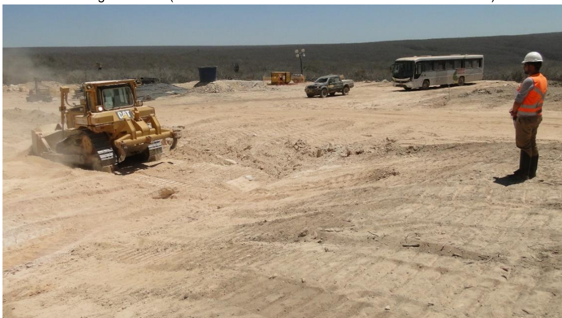
Figura 39 - Equipe técnica de arqueologia realizando o monitoramento da área da praça do Aerogerador 11. (COORDS UTM SIRGAS 2000 24 L 0227907/8837115).
