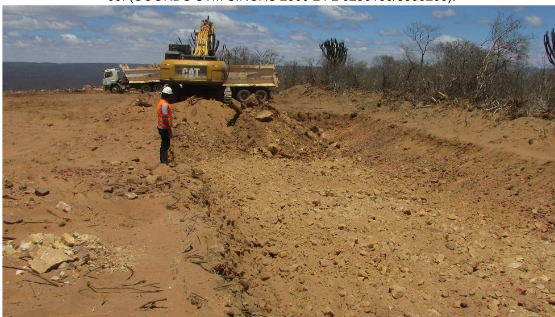
Figura 35 - Monitoramento arqueológico das atividades de terraplanagem na área do acesso 09. (COORDS UTM SIRGAS 2000 24 L 0230188/8835293).
