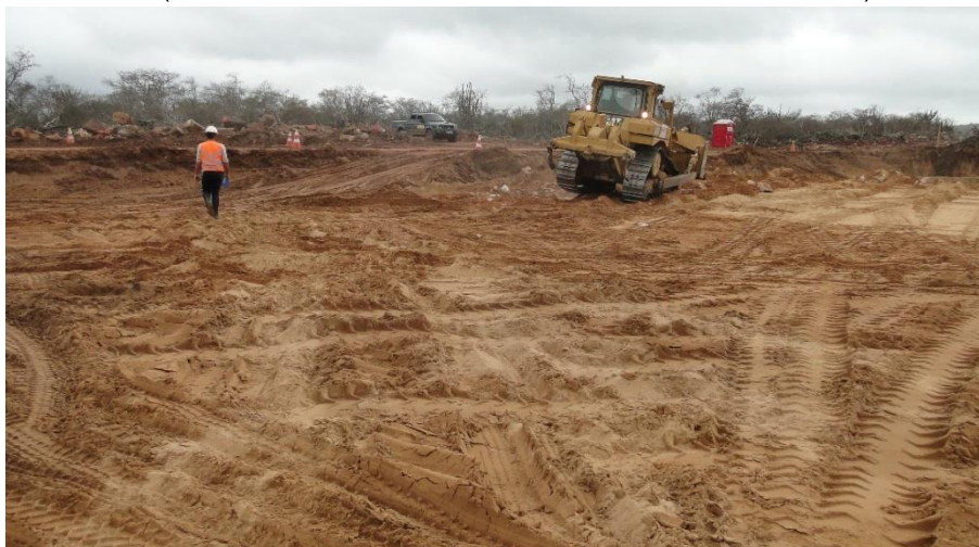
Figura 44 - Monitoramento arqueológico da remoção de sedimento da praça do aerogerador 03. (COORDS UTM SIRGAS 2000 24 L 0231093/8836496).
