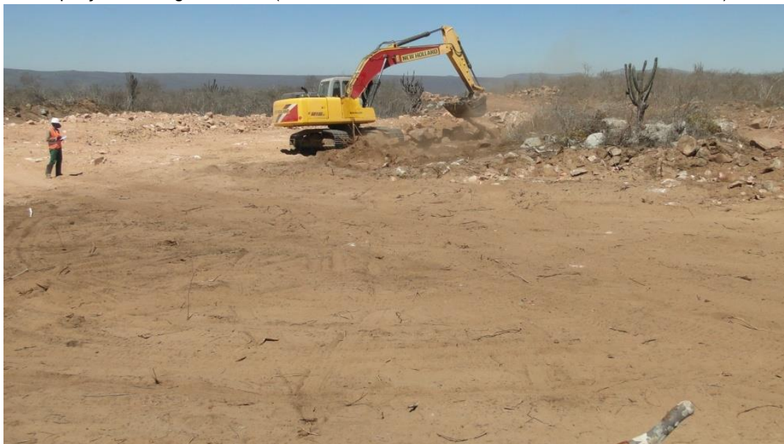
Figura 30 - Acompanhamento arqueológico da atividade de supressão vegetal mecanizada da praça do aerogerador 05. (COORDS UTM SIRGAS 2000 24 L 0230710/8836077).
