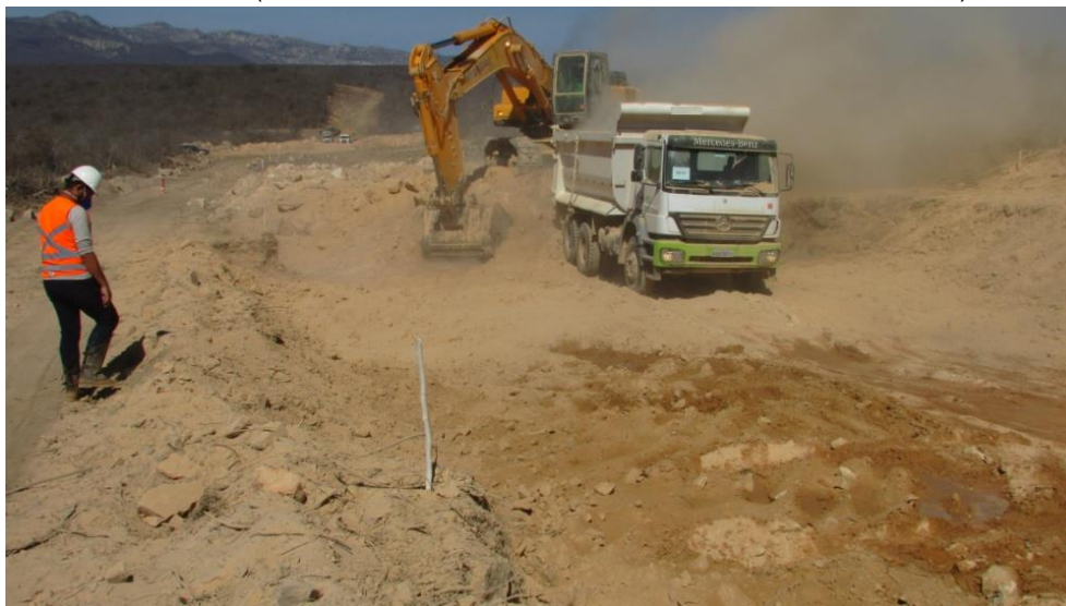
Figura 24 - Técnico em arqueologia inspecionando as atividades de terraplanagem da via de acesso 05. (COORDS UTM SIRGAS 2000 24 L 0221636/8836599).
