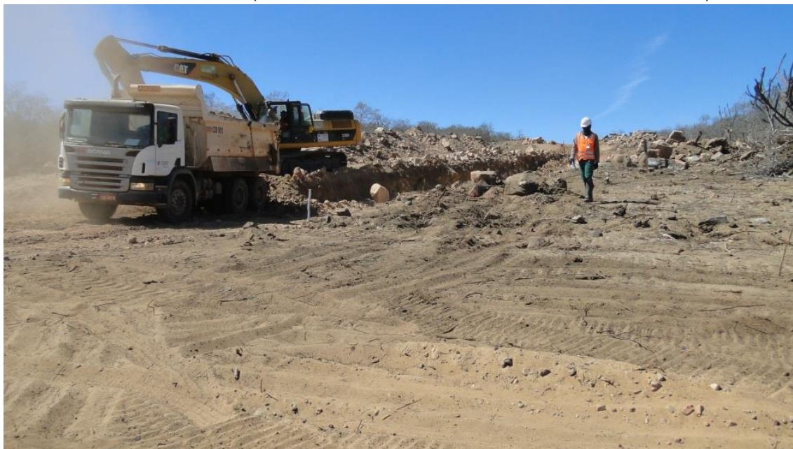
Figura 29 - Equipe técnica de arqueologia realizando o monitoramento e caminhamento na área do acesso 07. (COORDS UTM SIRGAS 2000 24 L 0230540/8835798).
