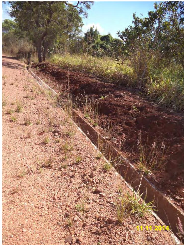
**Foto 45 - Detalhe do dispositivo de drenagem pluvial ao longo de acesso interno da RPPN Reserva do Jacob**
