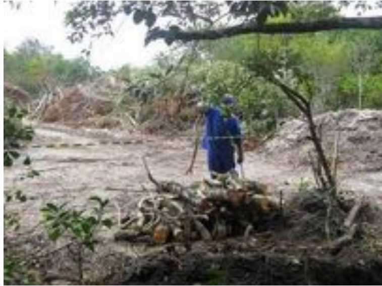
Figura 5.4-2: Exemplo do procedimento de organização e empilhamento do material suprimido.
