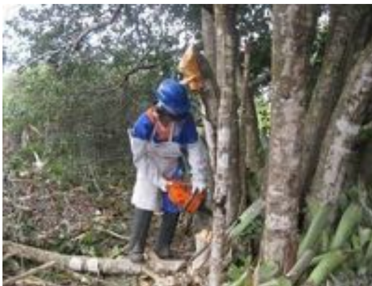
Figura 5.4-1: Exemplo do procedimento de derrubada de árvores e desdobramento da madeira com motosserra.
