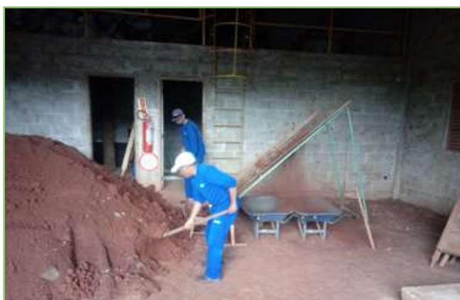
Figura 6.12 - Peneiramento de solo para preparação de substrato composto.
