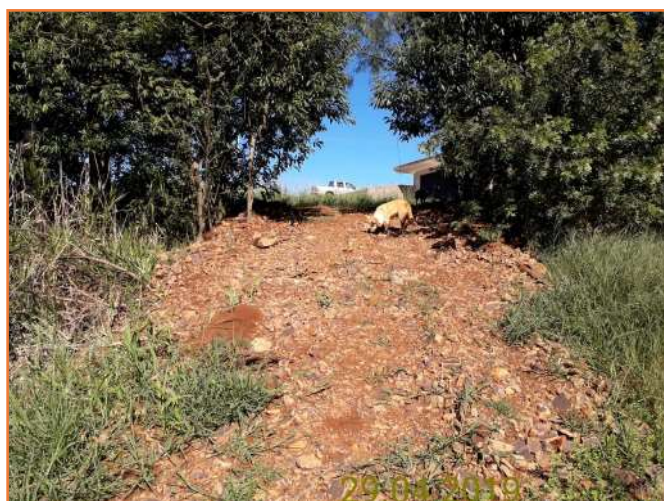
Figura 8.5 - Abertura de acesso irregular em área de APP no município de Ronda Alta-RS.
