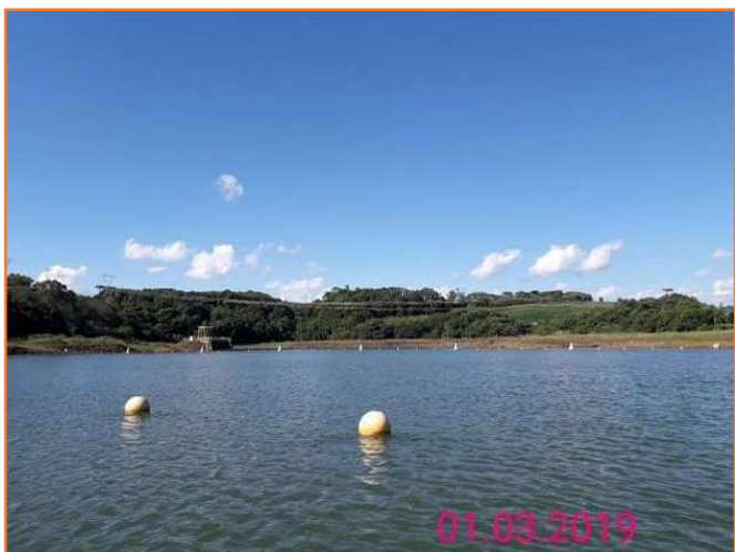
Figura 8.23 - Vistoria para avaliação da sinalização náutica.
