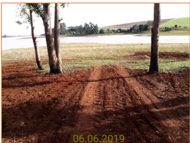
Figura 8.4 - Movimentação de terra em área de APP, Linha Progresso no município de Cruzaltense-RS.
