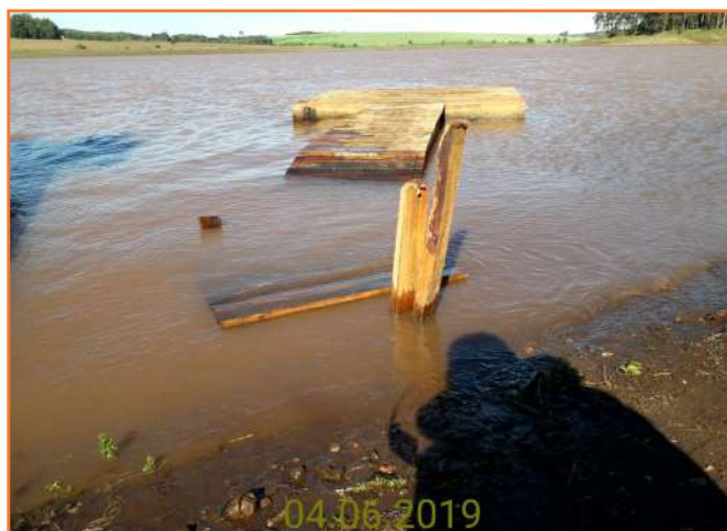
Figura 8.14 - Vistoria complementar para identificação de infrator no Condomínio Martinazzo, Campinas do Sul-RS.
