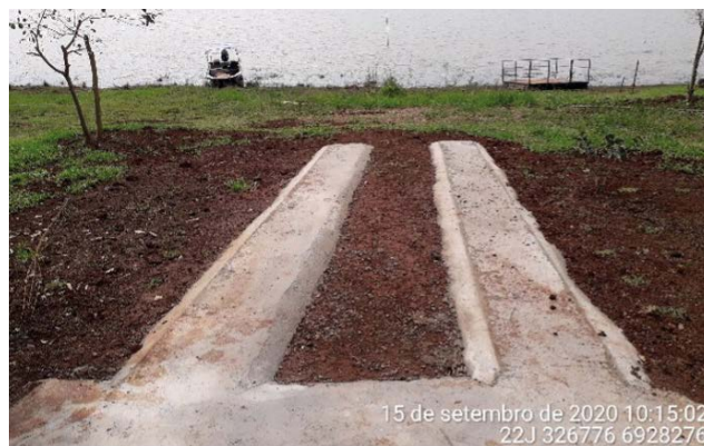
Figura 8.5 - Rampa de concreto construída em APP, Ronda Alta-RS.
