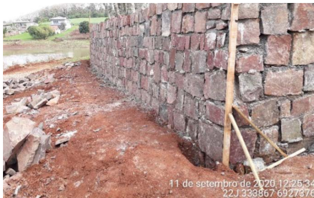
Figura 8.12 - Identificação de Infrator, Condomínio Martinazzo de Campinas do Sul-RS.
