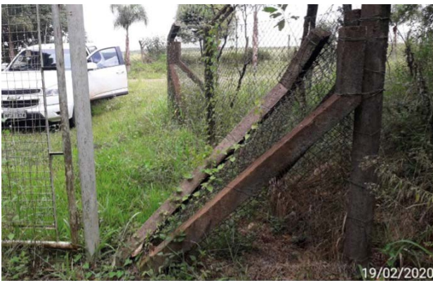
Figura 8.15 – Ocorrências gerais – Dano em cerca.
