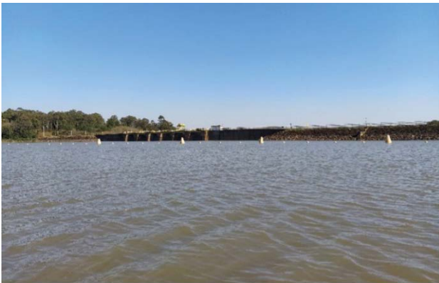
Figura 8.21 - Vistoria para avaliação da sinalização náutica.
