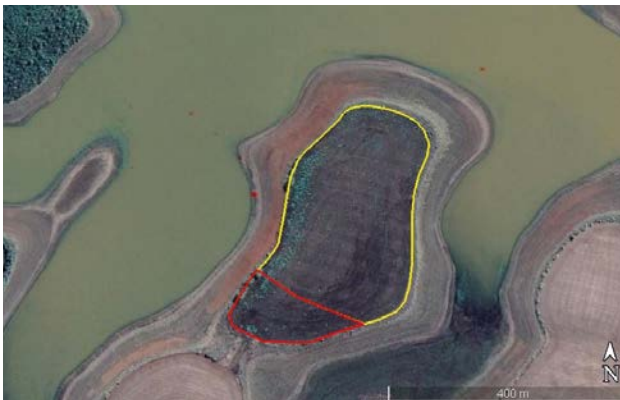
Figura 5.2 - Imagem de satélite da Ilha 16, delimitada em amarelo para a área em que foi realizado o plantio e, em vermelho, a área que ainda não foi executada – Fonte: Google Earth.
