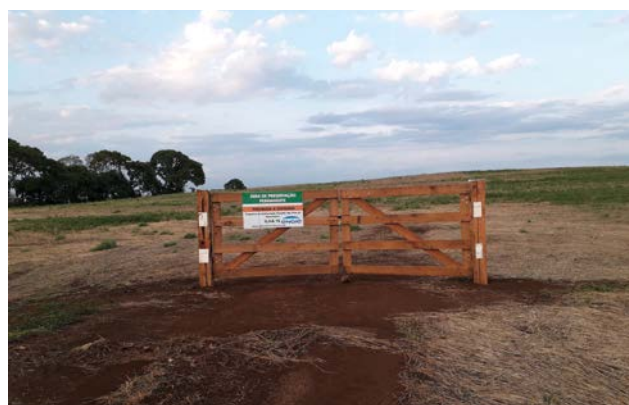
Figura 5.15 - Instalação de portão na Ilha 16.
