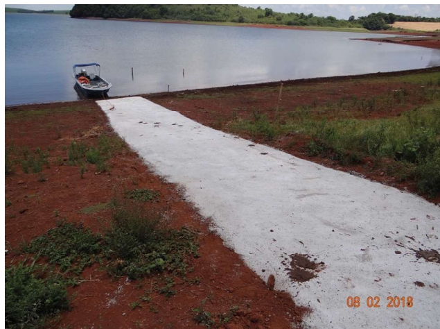
Figura 8.4 – Rampa construída irregularmente em área de APP no Condomínio Três Cerros, Campinas do Sul/RS.
