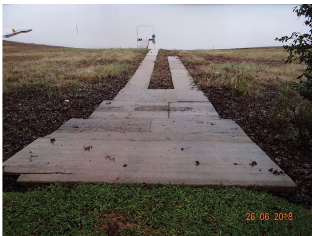
Figura 8.13 – Vistoria complementar para verificação de cumprimento de prazo amigável.
