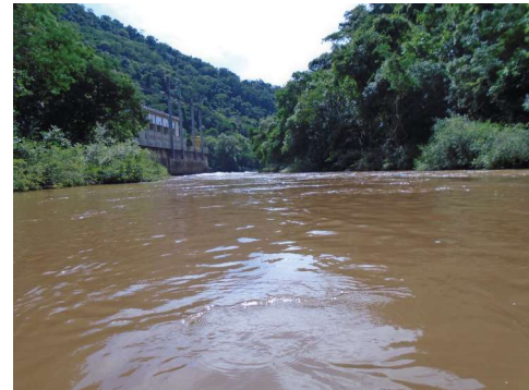
Figura 2.6 - P07 - Jusante da casa de força.
