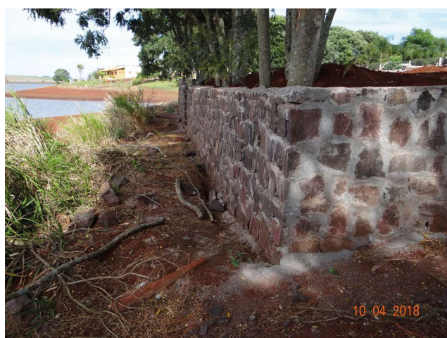
Figura 8.6 – Muro de contenção construído na cota de desapropriação no Condomínio Martinazzo, Campinas do Sul/RS.
