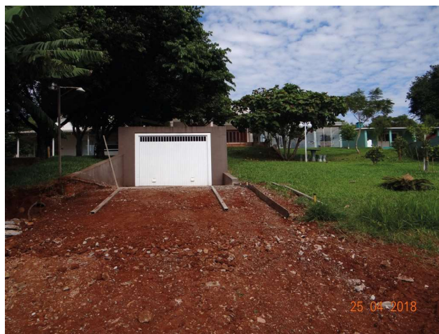
Figura 8.14 - Vistoria complementar para verificação de cumprimento de prazo amigável.
