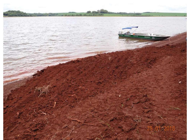
Figura 8.7 – Movimentação de terra em área de APP no Condomínio Martinazzo, Campinas do Sul/RS.
