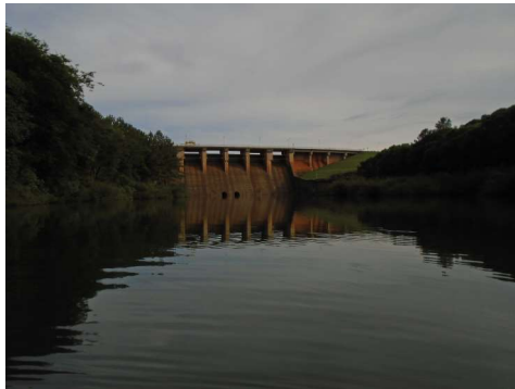
Figura 2.5 - P06 - Jusante do Barramento.
