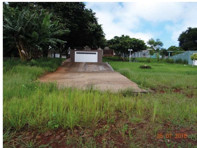
Figura 8.5 - Rampa construída irregularmente em área de APP no Condomínio Park das Águas, Ronda Alta/RS.
