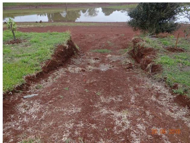
Figura 8.3 - Abertura de acesso irregular em área de APP no Condomínio Primavera, Ronda Alta/RS.
