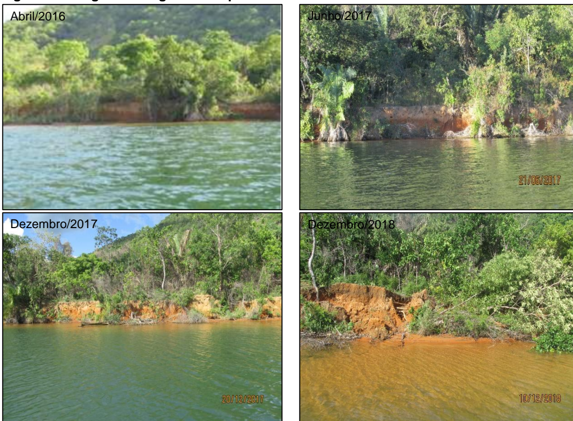
Figura 21 - Registro fotográfico do ponto P22
