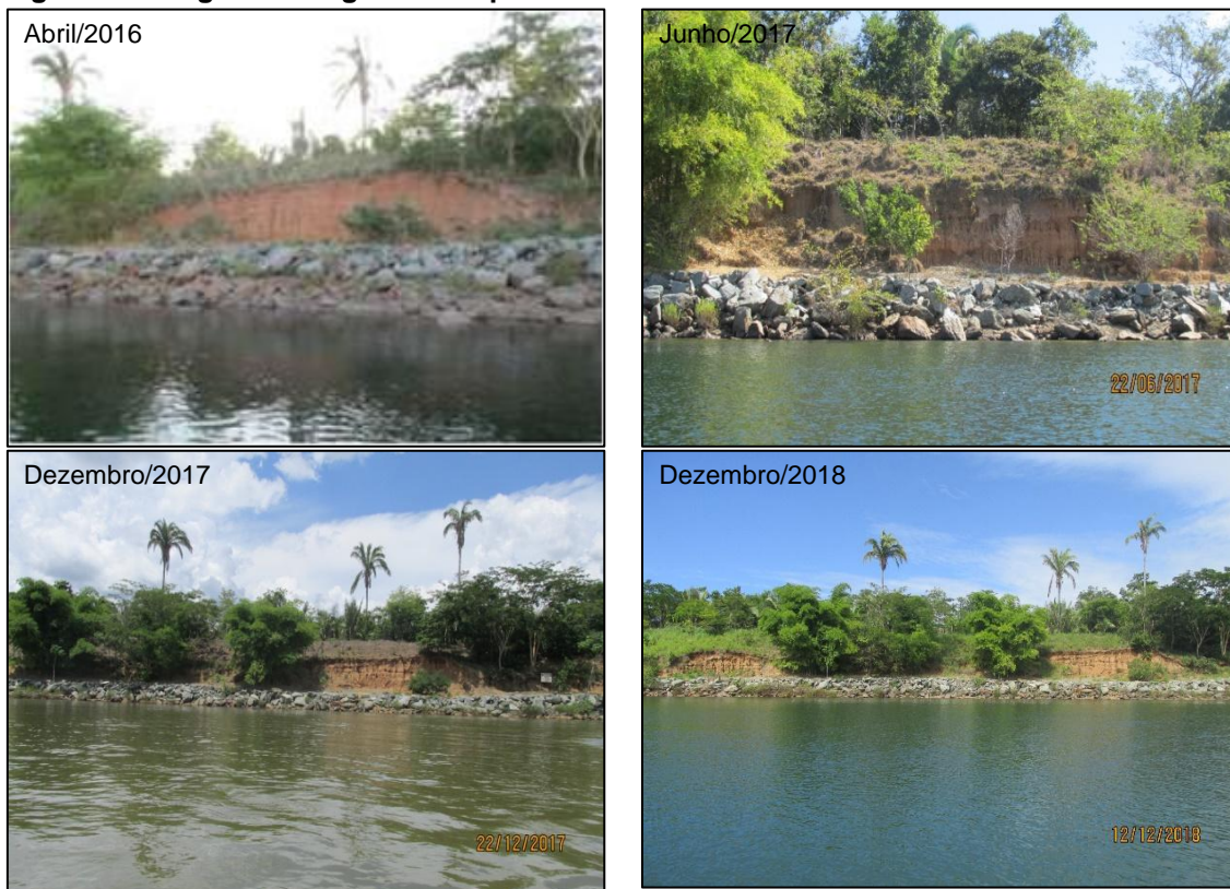
Figura 22 - Registro fotográfico do ponto P23
