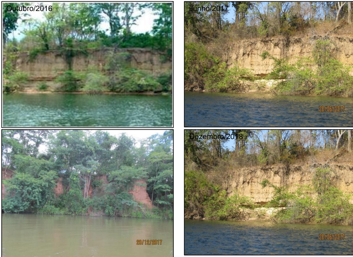
Figura 18 - Registro fotográfico do ponto P12
