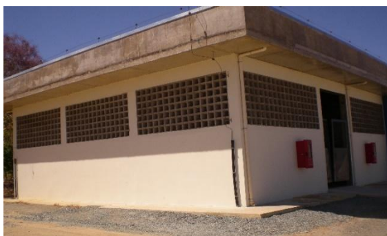
Local de armazenamento de resíduos
