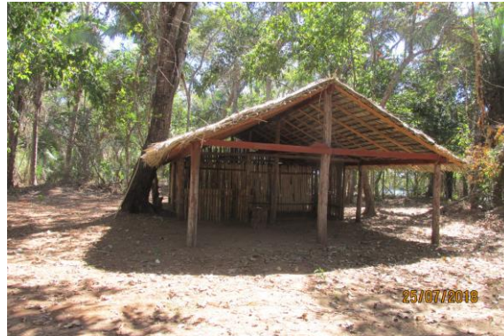
Construção irregular em APP.
