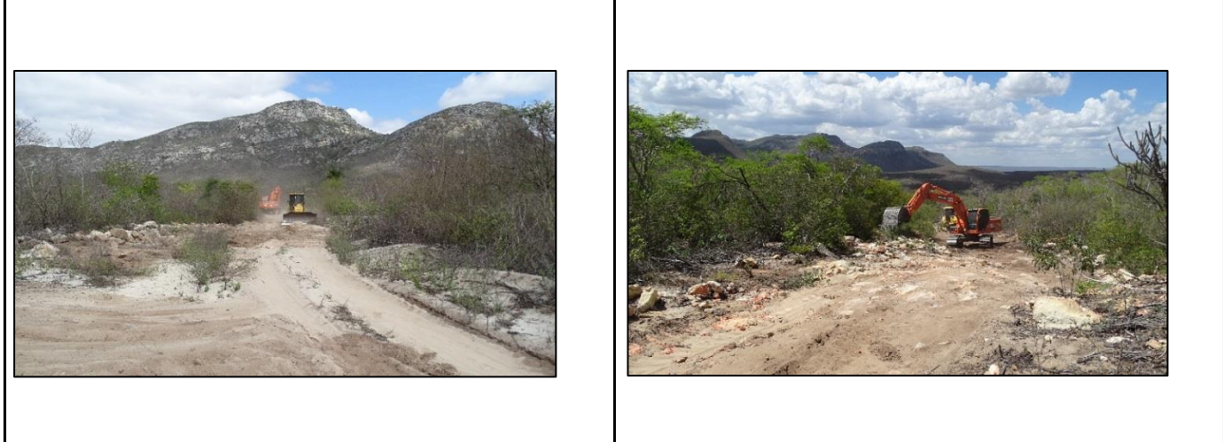
Legendas: Foto 1 e 2 - Melhorias do acesso existente
