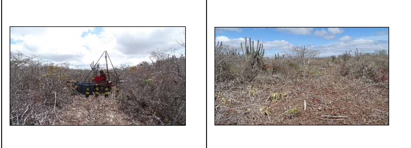
Legendas: Fotos 1 - Área de implantação do aerogerador UMB_19_09 - Foto 2 Área de implantação do aerogerador UMB_19_10
