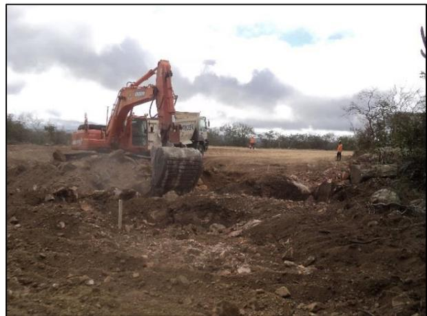
Legendas: Foto 1 - Monitoramento de escavação da base do aerogerador UMB\_13\_04; Foto 02 - Monitoramento de escavação da base
