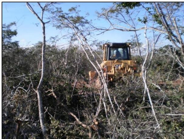
Legendas: Foto 1 - Supressão vegetal mecanizada do bota fora\_05 ; Foto 02 - Supressão vegetal mecanizada do bota fora\_05
