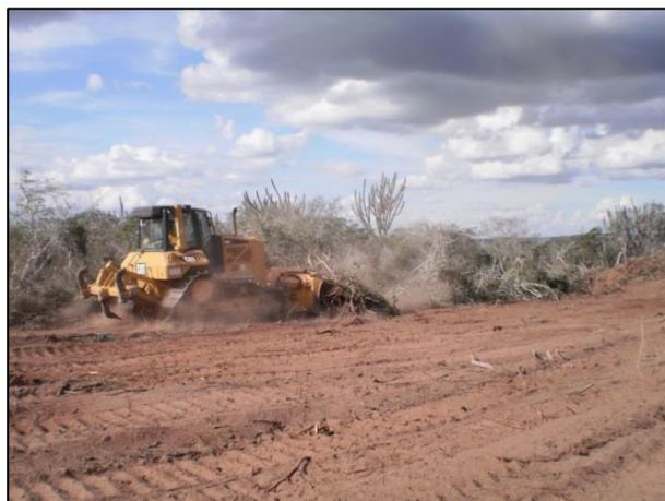
Legendas: Foto 1 - Supressão vegetal mecanizada da base UMB\_13-07 ; Foto 02 - Supressão vegetal mecanizada da base UMB\_13-07
