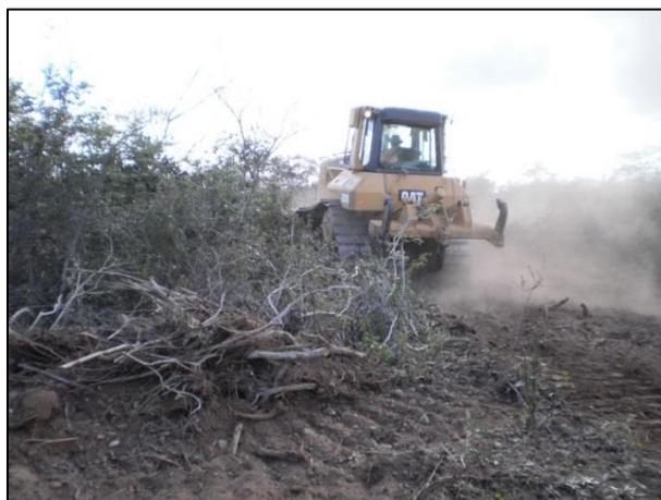
Legendas: Foto 1 - Supressão vegetal mecanizada da base UMB\_13-08 ; Foto 02 - Supressão vegetal mecanizada da base UMB\_13-08
