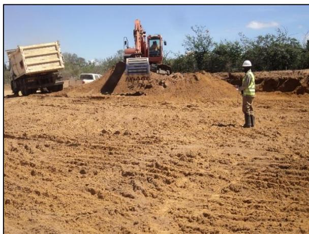
Legendas: Foto 1 -Monitoramento de escavação da base do aerogerador UMB\_16\_06; Foto 02 - Monitoramento de escavação da base do
