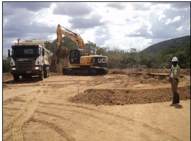
Legendas: Foto 1 -Monitoramento da remoção de sedimento na via do aerogerador UM UMB\_08\_07; Foto 02 -Monitoramento de escavação da base do aerogerador UM UMB\_08\_01
