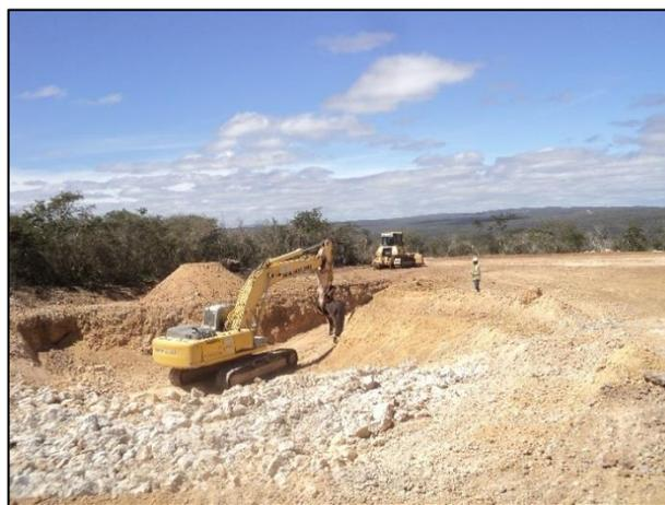
Legendas: Foto 1 - Monitoramento de escavação da base do aerogerador UMB\_13\_05; Foto 02 - Monitoramento de escavação da base do aerogerador UMB\_13\_06
