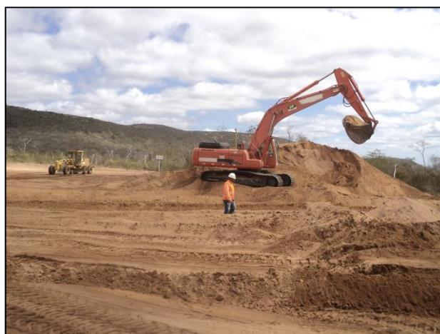
Legendas: Foto 1 -Monitoramento de escavação da praça do aerogerador UM UMB\_21\_09; Foto 02 - Monitoramento de escavação da praça do aerogerador UM UMB\_21\_09
