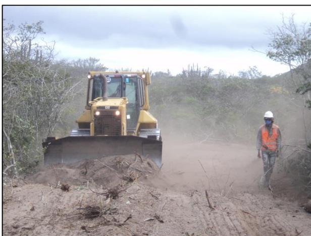
Legendas: Foto 1 -Monitoramento de supressão vegetal mecanizada da UM RMT\_TRECHO\_01; Foto 02 - Monitoramento de supressão vegetal mecanizada da UM RMT\_TRECHO\_01
