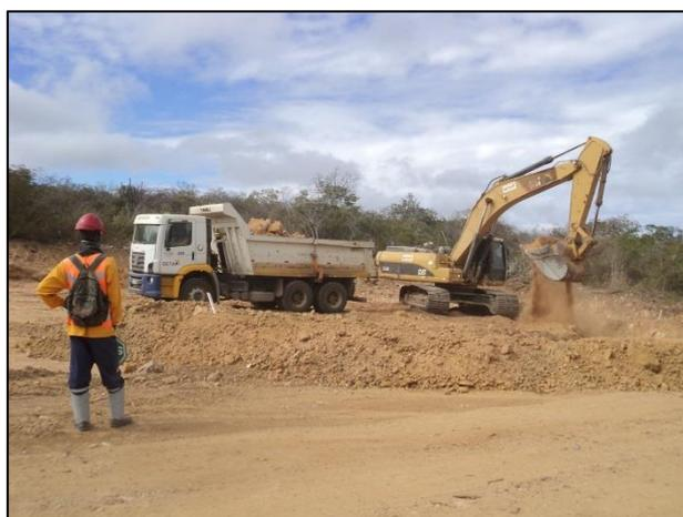
Legendas: Foto 1 -Monitoramento de escavação da base do aerogerador UM UMB\_08\_10; Foto 02 - Monitoramento de escavação da base do aerogerador UM UMB\_08\_10
