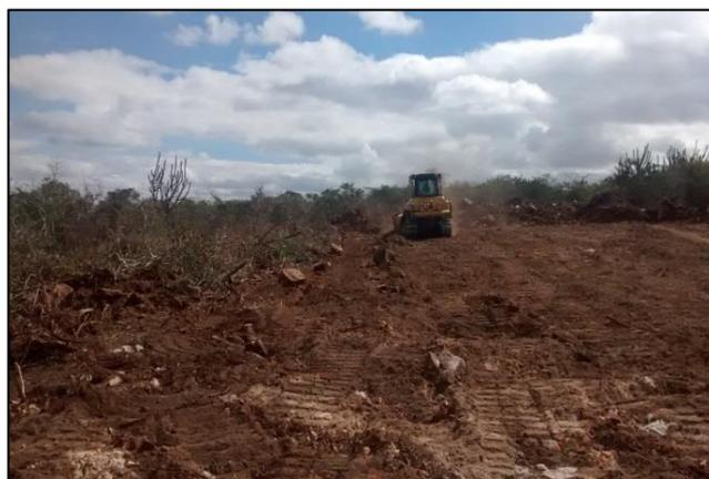
Legendas: Foto 1 - Supressão manual e semi mecanizada - Foto 2 - Supressão mecanizada
