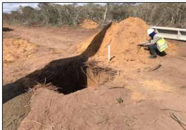
Legendas: Fotos 1 e 2 - Escavação para implantação de posteamento - RMT\_TRECHO 2 (UMB\_17)
