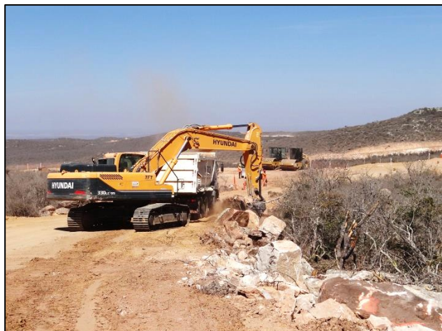
Legendas: Foto 1 - Supressão mecanizada por escavadeira com esteira;
