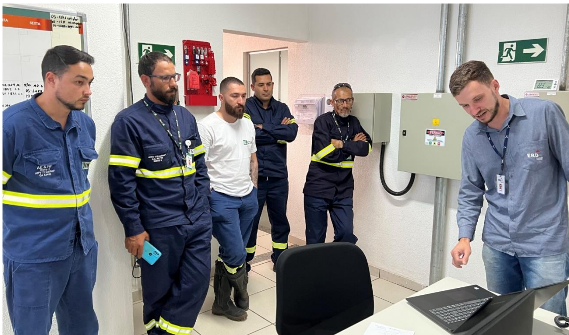
Figura 1.78. Realização Campanha I - Subestação Ivaiporã.
