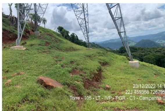
Figura 1.6. IVP-PGR C1 T 105 em ótimo estado de recuperação.
