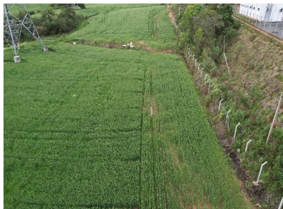
Figura 1.6. Vista da área utilizada como acesso as obras de implantação da SE. Fonte: Gralha Azul , 2022.
