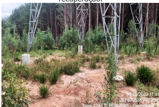
Figura 1.6. PGR-SMS T 127 em bom estado de recuperação.
