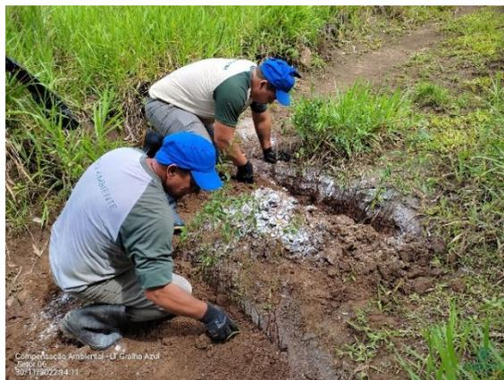
Figura 1.54. Adensamento de espécies para controle de erosivos.
