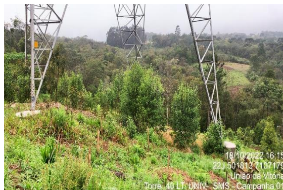
Figura 1.7 . UVN-SMS T 40 em ótimo estado de recuperação.
