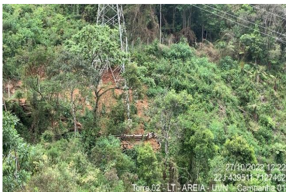
Figura 1.5. ARE-UVN T 02 em bom estado de recuperação.
