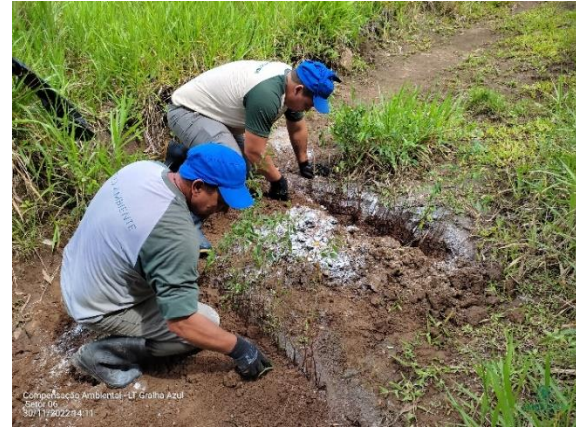
Figura 1.58. Adensamento de espécies para controle de erosivos.
