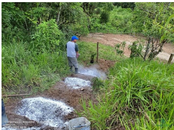
Figura 1.54. Realização do plantio para controle de erosivos.
