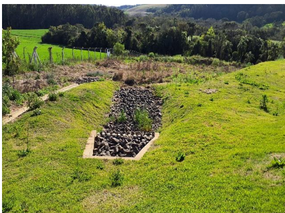
Figura 1.6. Vista do dissipador de energia implantado na AA 02.
