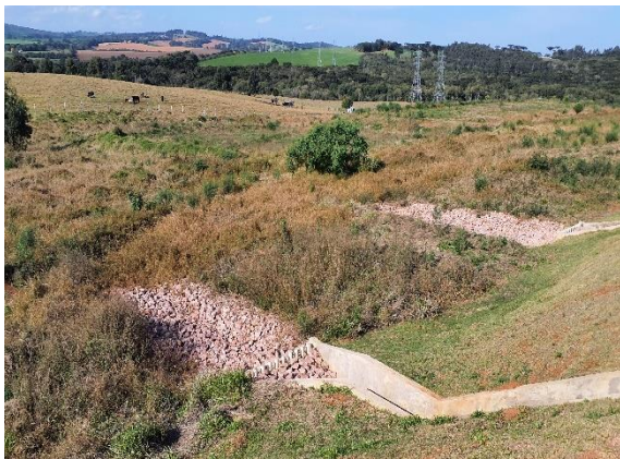
Figura 1.7. Vista dispositivos de drenagem da AA 02.
