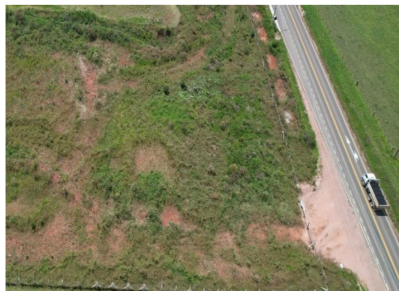
Figura 1.14. Vista da AA 04 em recuperação. Fonte: Ecoequilibrium Consultoria LTDA.
