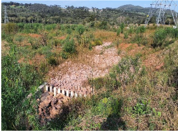
Figura 1.11. Vista da AA 03 em recuperação. Fonte: Ecoequilibrium Consultoria LTDA.
