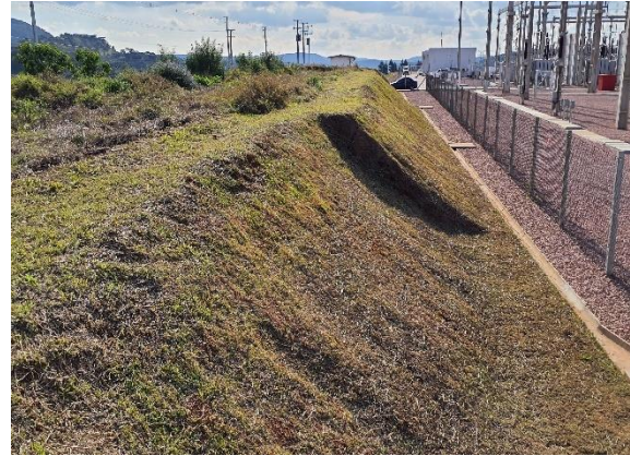
Figura 1.5. Vista da AA 01 em recuperação. Fonte: Ecoequilibrium Consultoria LTDA.
