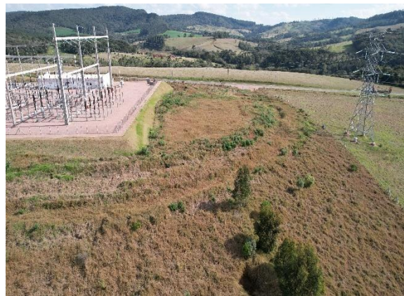
Figura 1.8. Vista da AA 02 revegetada.e com dispositivos de drenagem implantados.
